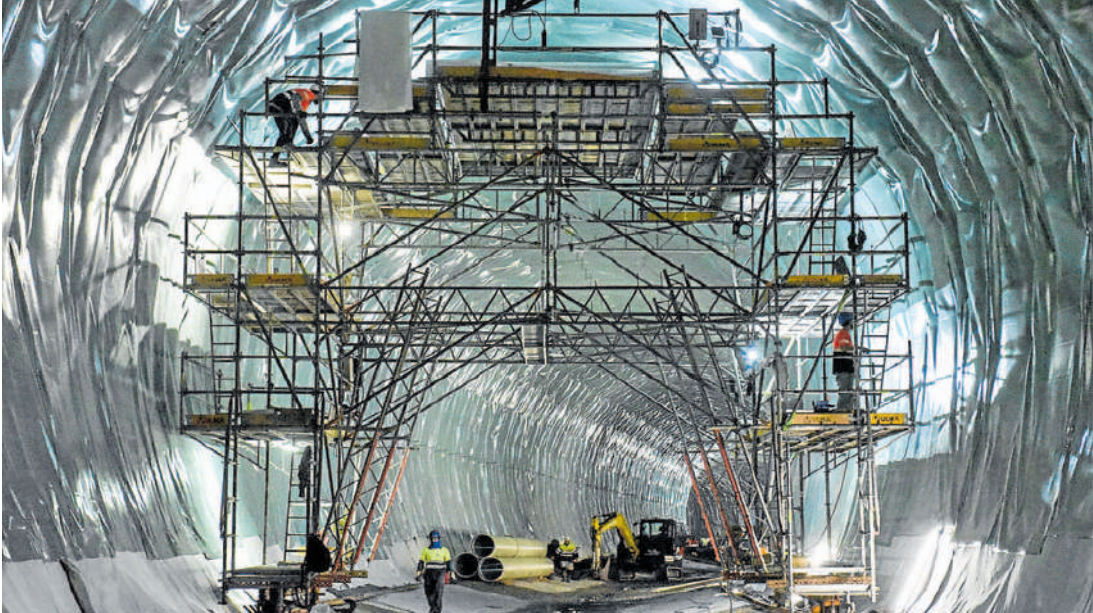
La galería subterránea que se encuentra en Barakaldo está siendo sometida en la actualidad a distintas labores de impermeabilización. YVONNE ITURGAIZ
