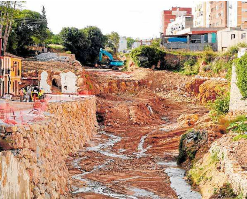
Obras de la Confederación del Júcar en Chiva a finales de octubre. LP
