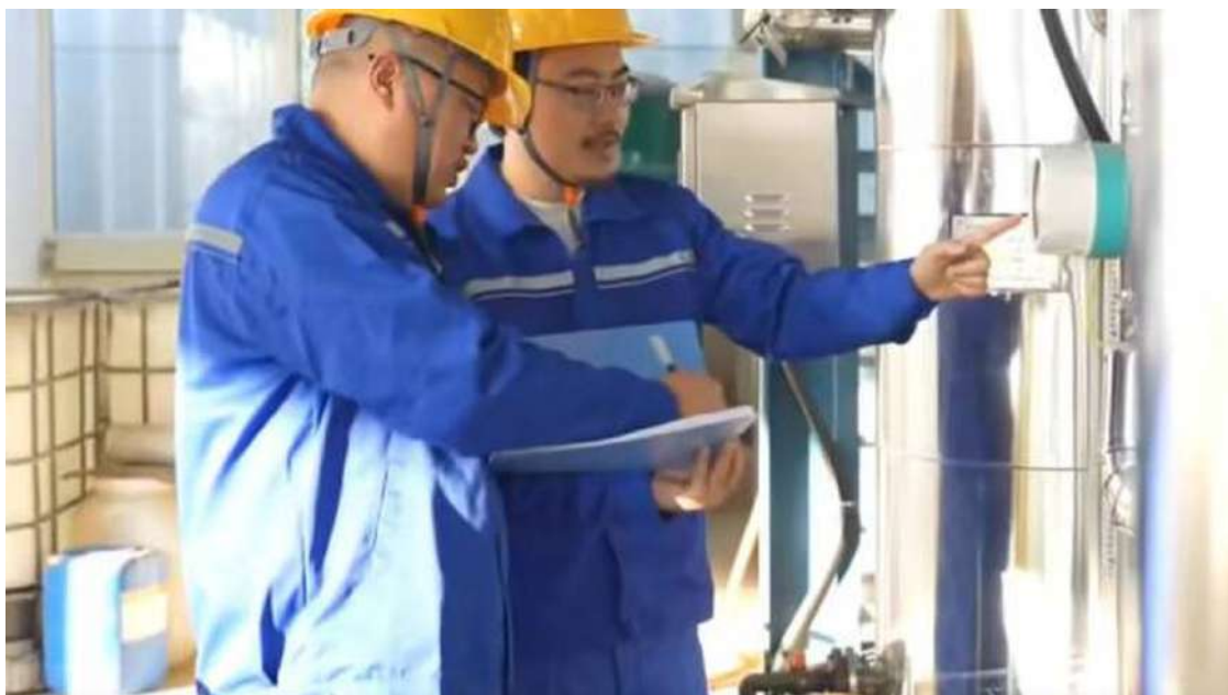
Dos operarios trabajan en la nueva planta desalinizadora de Rizhao.
